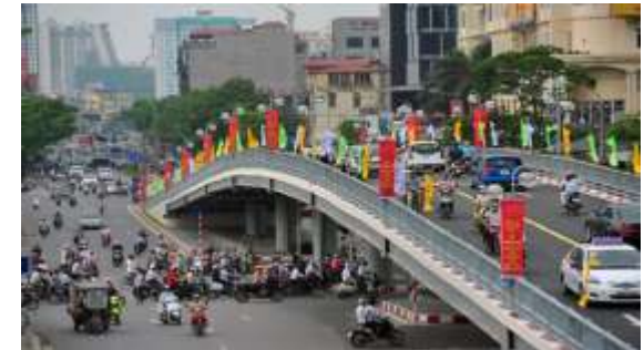
Cầu vượt Láng Hạ - Huỳnh Thúc Kháng, 189m
